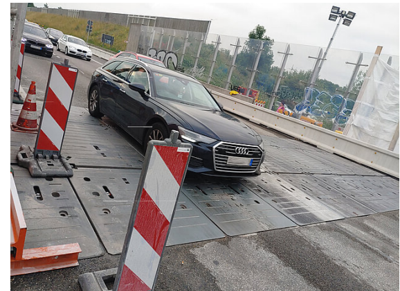
Bild 4 – Trafiken är påsläppt, modulplattor säkrade på båda sidor
