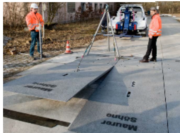
Bild 2-Tripod nyttjas för att höja och sänka modulplattor
